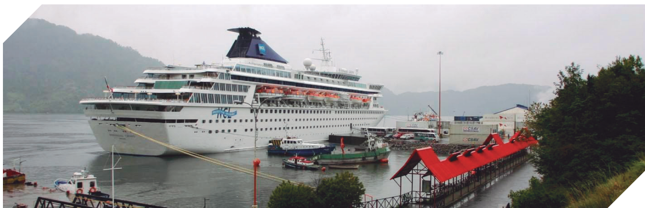
Imagen IX-B : Empresa Portuaria Chacabuco cuenta con 1 muelle flotante, ubicado inmediatamente al sur del muelle 1.
